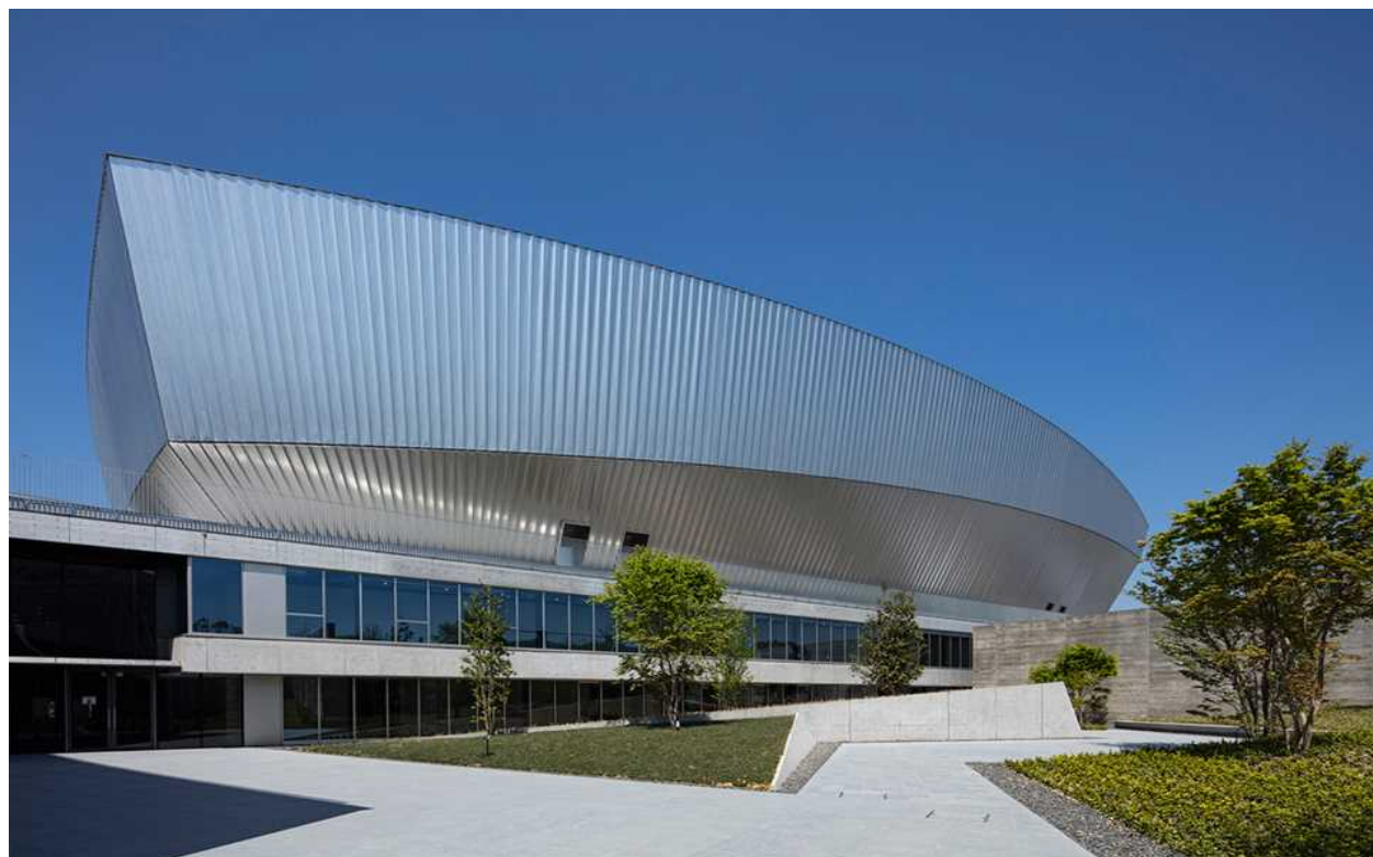
四日市市総合体育館
